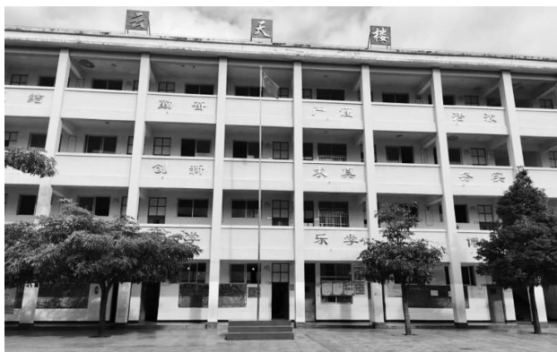
捐资修建的新教学楼
