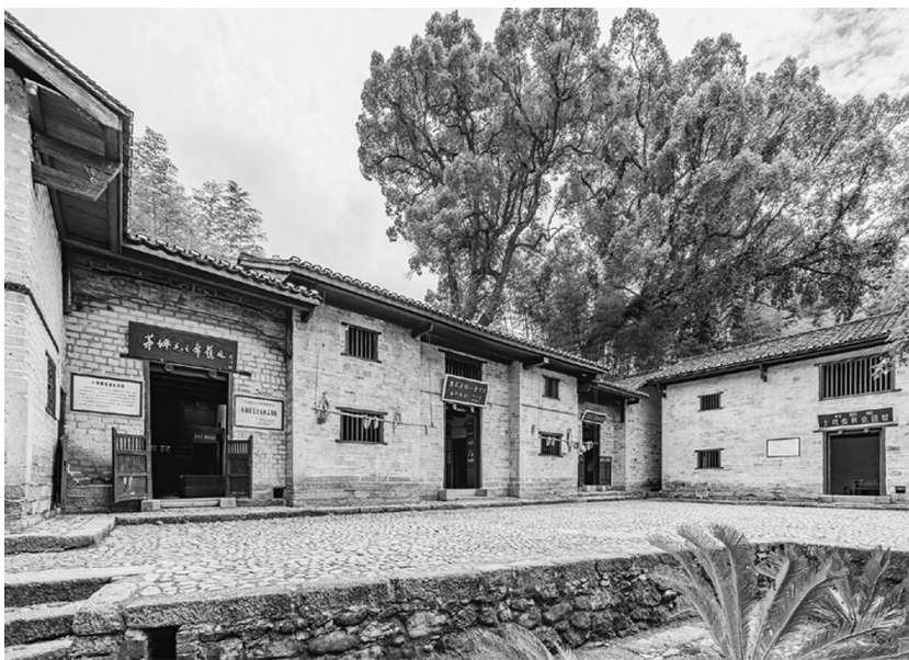
（图为修缮后的八角楼）
